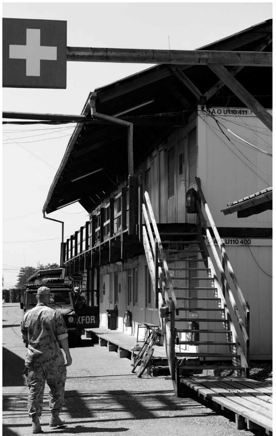
Überdachte Container bilden den Stabstrakt an der «Longstreet», wo die Militärführung ihre Büros eingerichtet hat.
