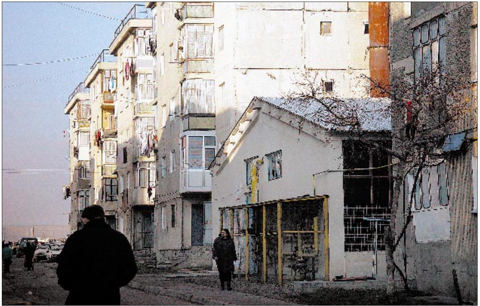
Veraltet Die meisten rumänischen Wohnblocks werden mit Fernwärmezentralen (Mitte) geheizt – mit grossen Energieverlusten.
